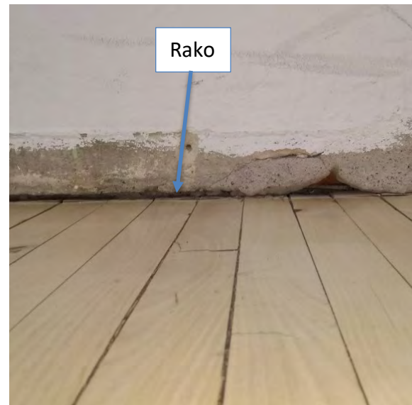
Kuva 57 Liikuntasalin lattia rakenteet eivät ole tiiviit.
