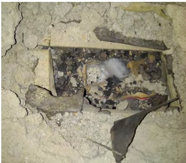
Kuva 52 Rakenneavaus 14 kivikoulun A-osan ullakolla.
