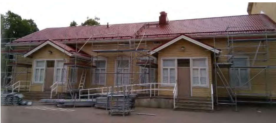
Kuva 7 ...ja kattoremontin jälkeen.
