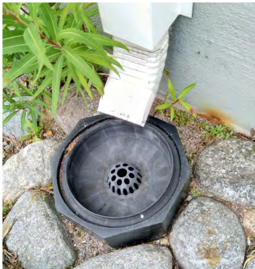
Kuva 12 Sadevesikaivot olivat siistit.
