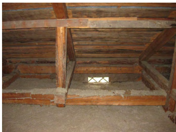
Kuva 40 Kattotuolirakenteita puukoululla.
