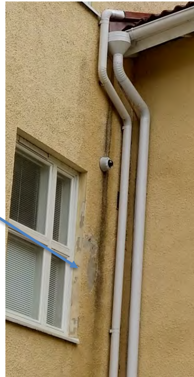
Kuva 33 Vuotaneiden vesikourujen/syöksytörvien aiheuttamaa vauriota.
