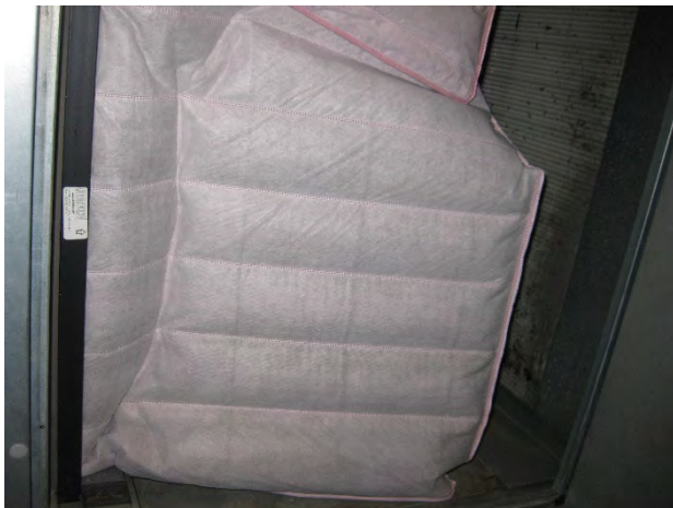
Kuva 70 Suodattimien ohivirtausta
