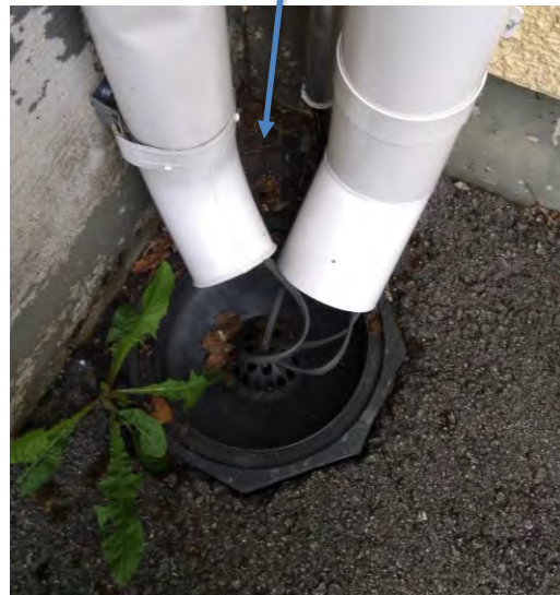
Kuva 13 Lämmityskaapelit syöksytörvissa.
