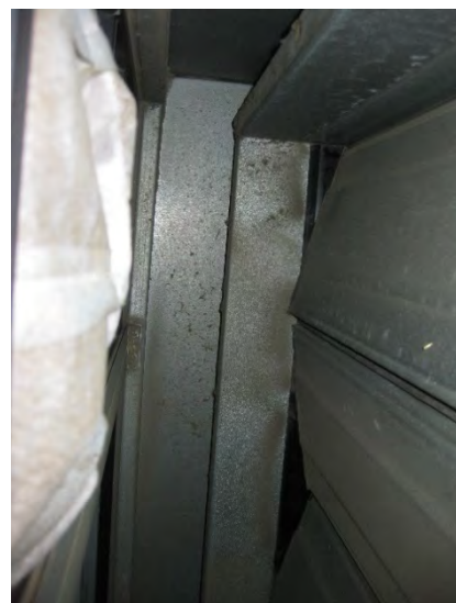
Kuva 73 Sulkupellin ympärillä merkkejä ohivirtauksesta
