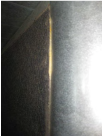
Kuva 80 Äänenvaimentimen pinnoite vaurioitunut
