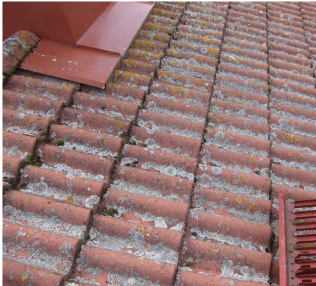
Kuva 48 Kivikoulun katolla on runsaasti jäkälää ja jonkin verran sammalta.
