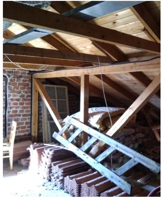
Kuva 43 Kivikoulun A-osan ullakolla oli varastoituna mm. tiiliä.
