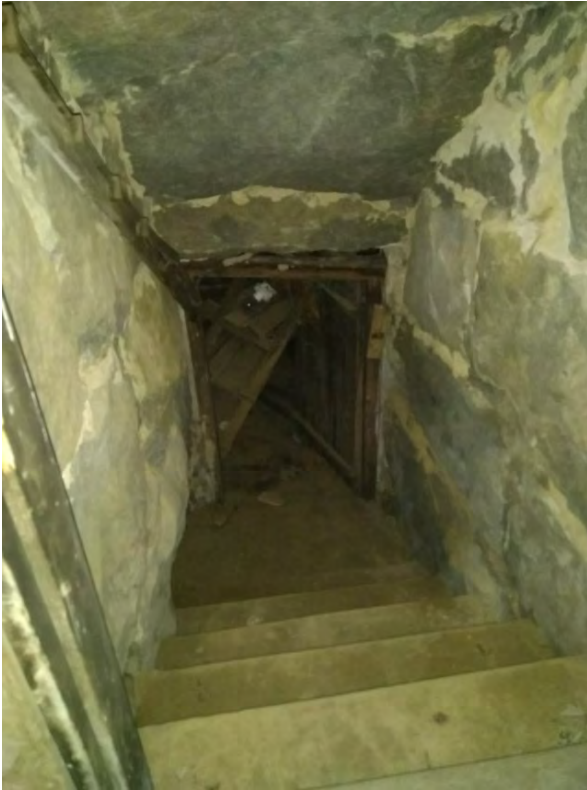
Kuva 26 Kellari puukoulun alapohjassa
