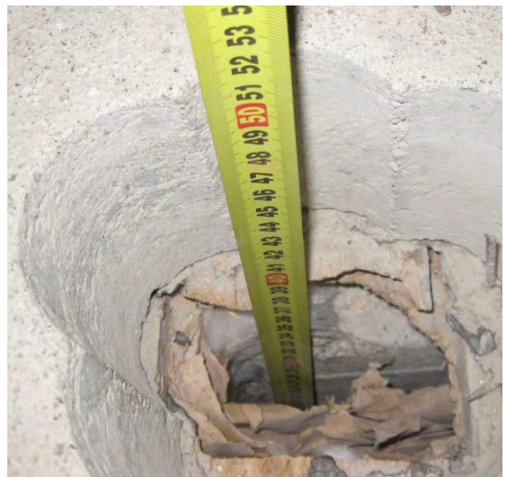
Kuva 53 Rakenneavaus 15 kivikoulun A-osan ullakolla.
