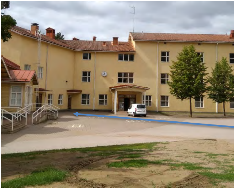
Kuva 8 Piha viettää rakennuksen kulmaan.
