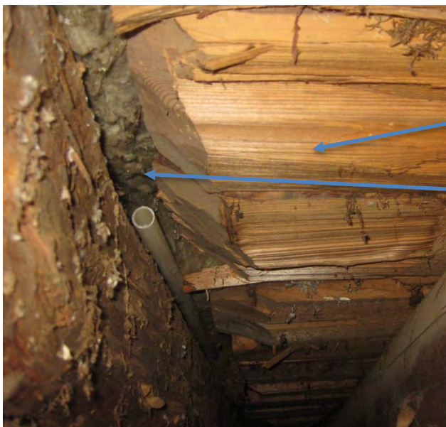
Kuva 25 Puukoulun rossipohjalaudoituksen liittyminen seinärakenteeseen.
