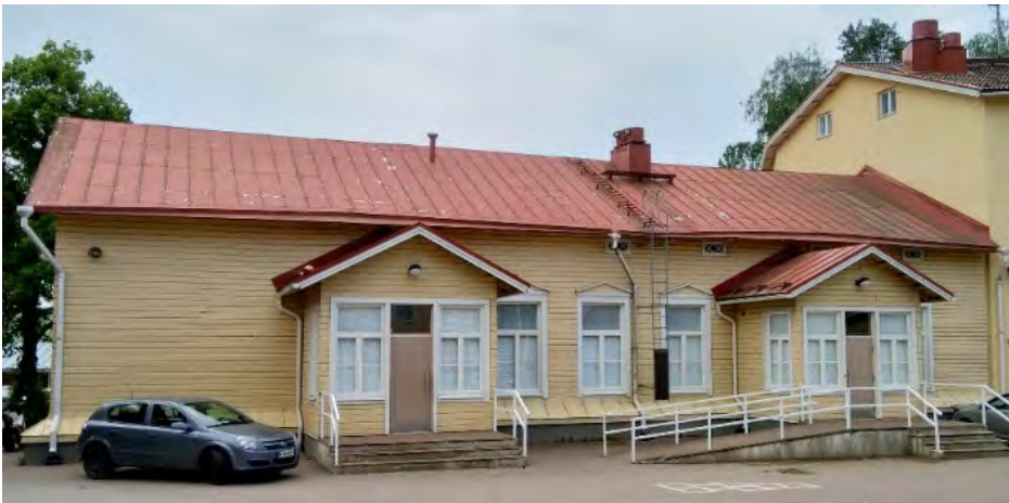
Kuva 6 Puukoulu ennen kattoremonttia...
