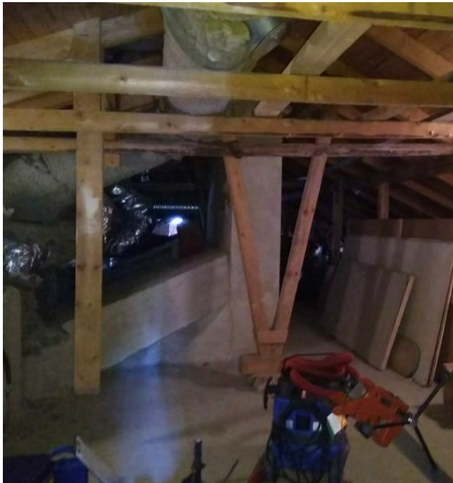
Kuva 42 Kivikoulun A-osan ullakkoa.
