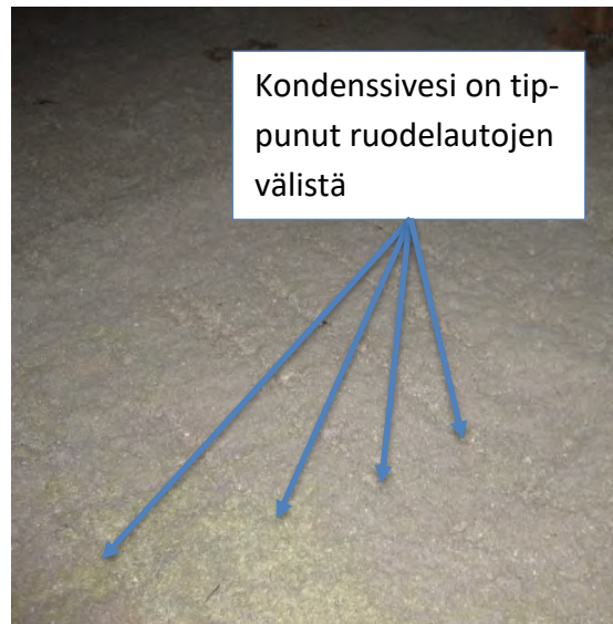
Kuva 39 Selluvilla oli kovettunut noin 50 mm pinnasta.
