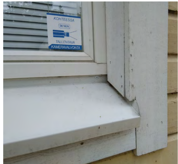
Kuva 31 Puukoulun ikkunoiden vesipeltien kallistukset ja kiinnitykset ovat hyvin tehtyjä.
