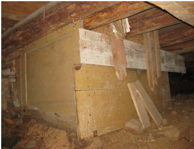
Kuva 21 Puukoulun ryömintätilassa oleva muottilaudoitus.
