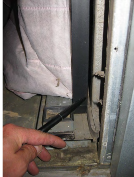
Kuva 77 Suodatinkehys epätiivis
