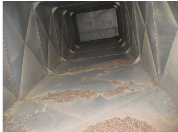
Kuva 69 Ulkoilmakammiossa roskaa
