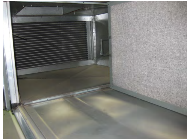
Kuva 65 Siitepölyä äänenvaimenninyksikössä sekä tuloilmakanavassa.
