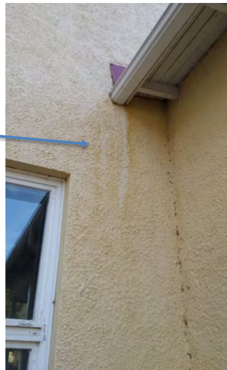
Kuva 33 Vuotaneiden vesikourujen/syöksytörvien aiheuttamaa vauriota.
