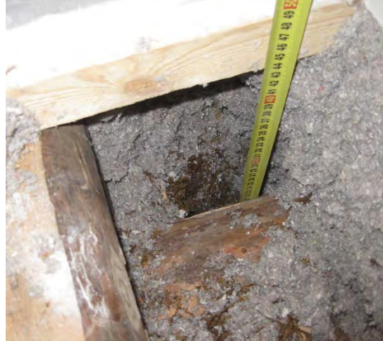
Kuva 28 Rakenneavaus 8 puukoulun luokassa C1.15
