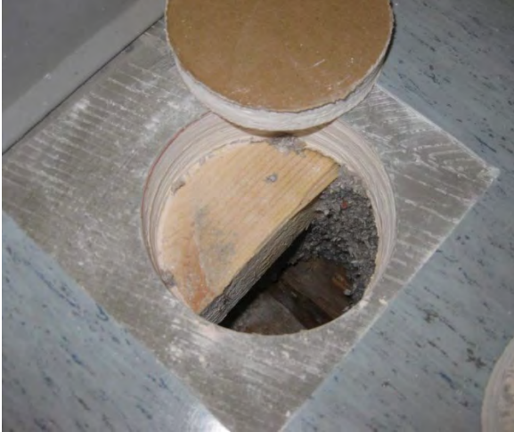
Kuva 27 Rakenneavaus 6 puukoulun luokassa C1.11
