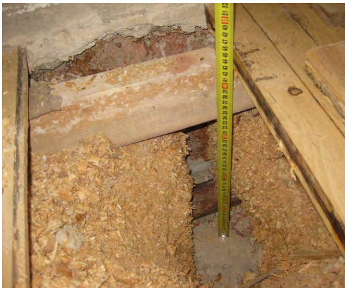
Kuva 56 Rakenneavaus 27 liikuntasalin lattiaan.
