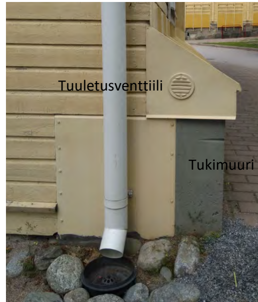
Kuva 22 Puukoulun maanvastainen tukimuri.
