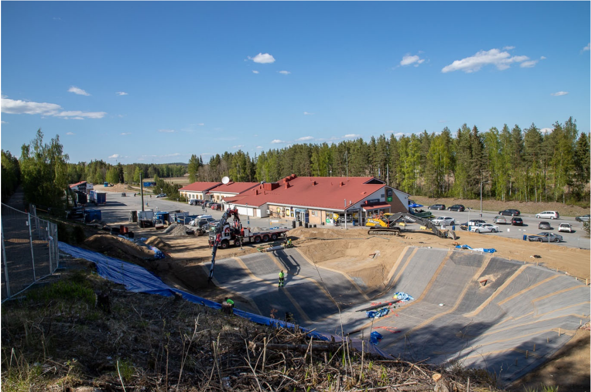
Aapiskukon alue toukokuussa 2022, jolloin uusi mittarikentän alue oli rakenteilla.
