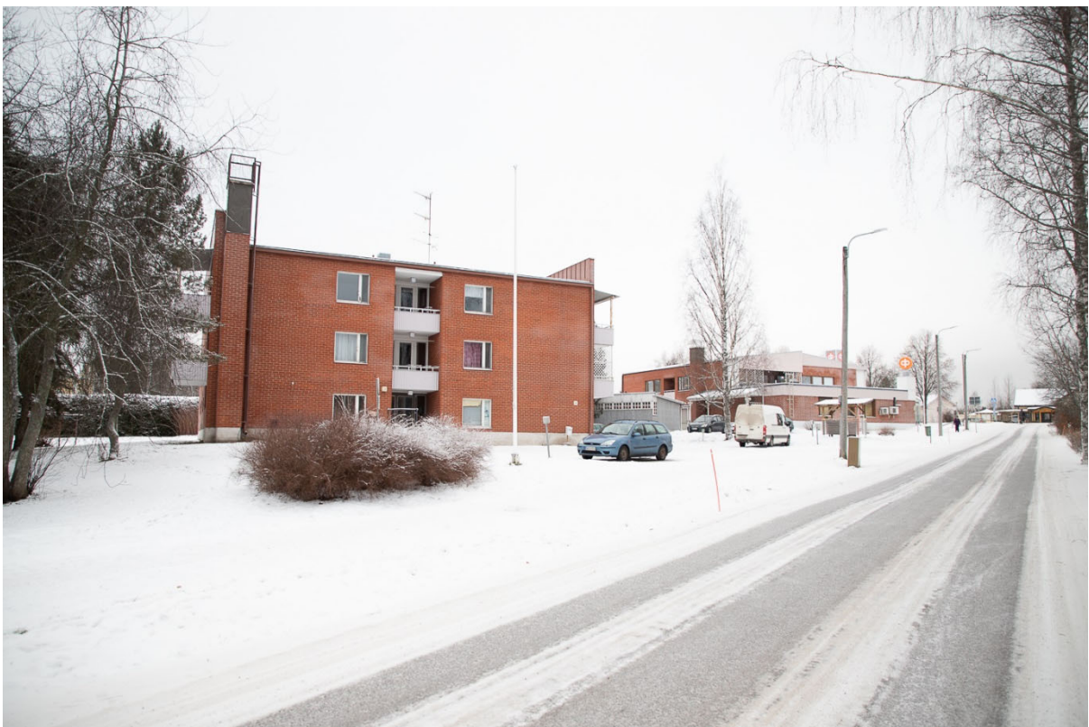
Rajalantiellä suunnittelualueen naapurina sijaitseva kerrostalo.
