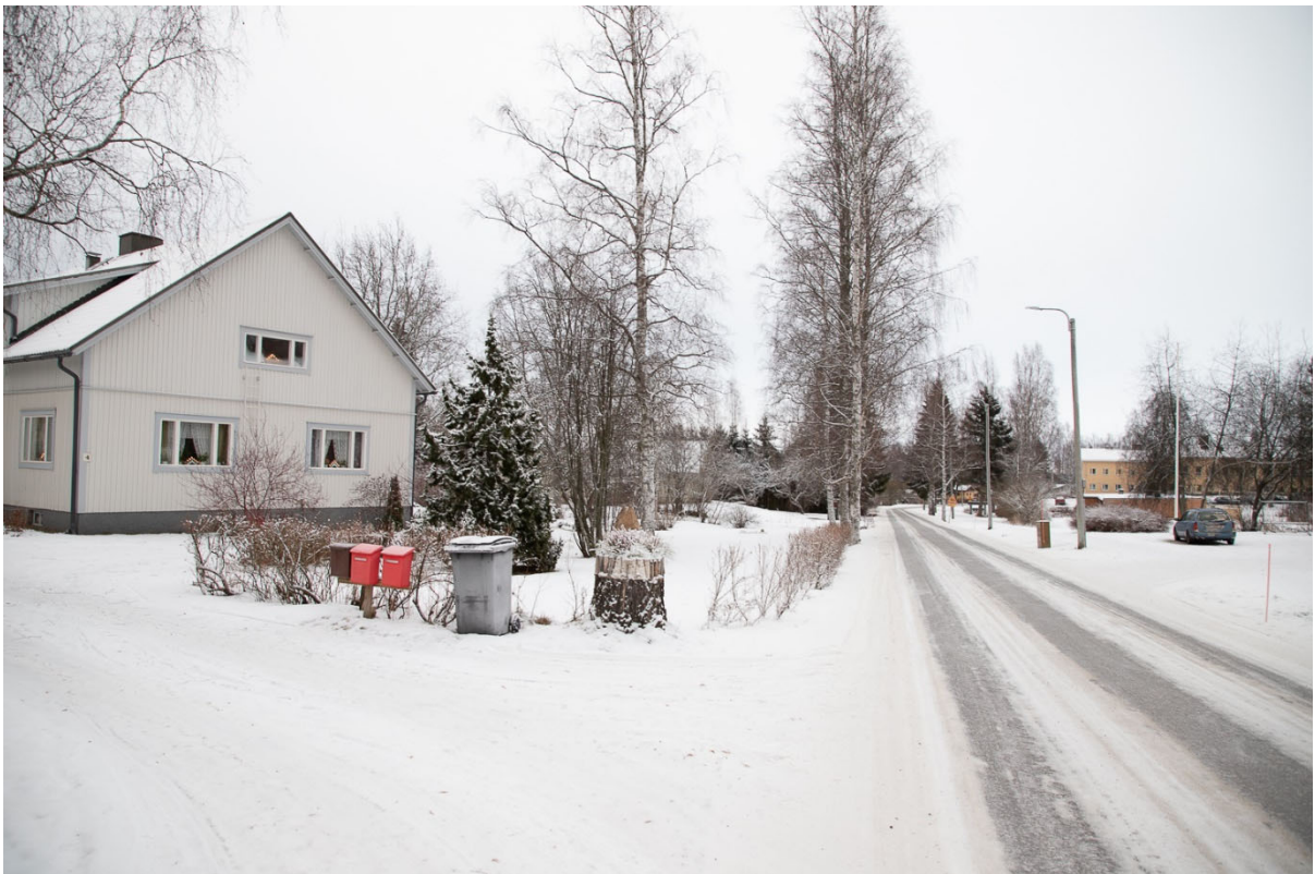
Rajalantien itäpuolen rakennuskantaa.
