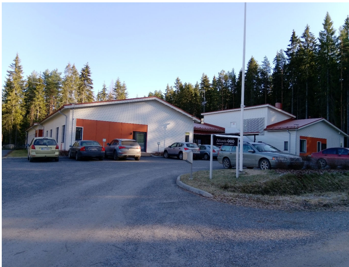
Hoivakoti Attendo Satumetsä Lastenlinnantien varrella. Kuva: Minna Aittola.
