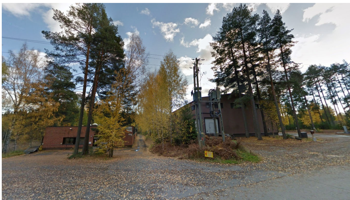
Takojantien varren teollisuusrakennukset. Lähde: Google Maps.
