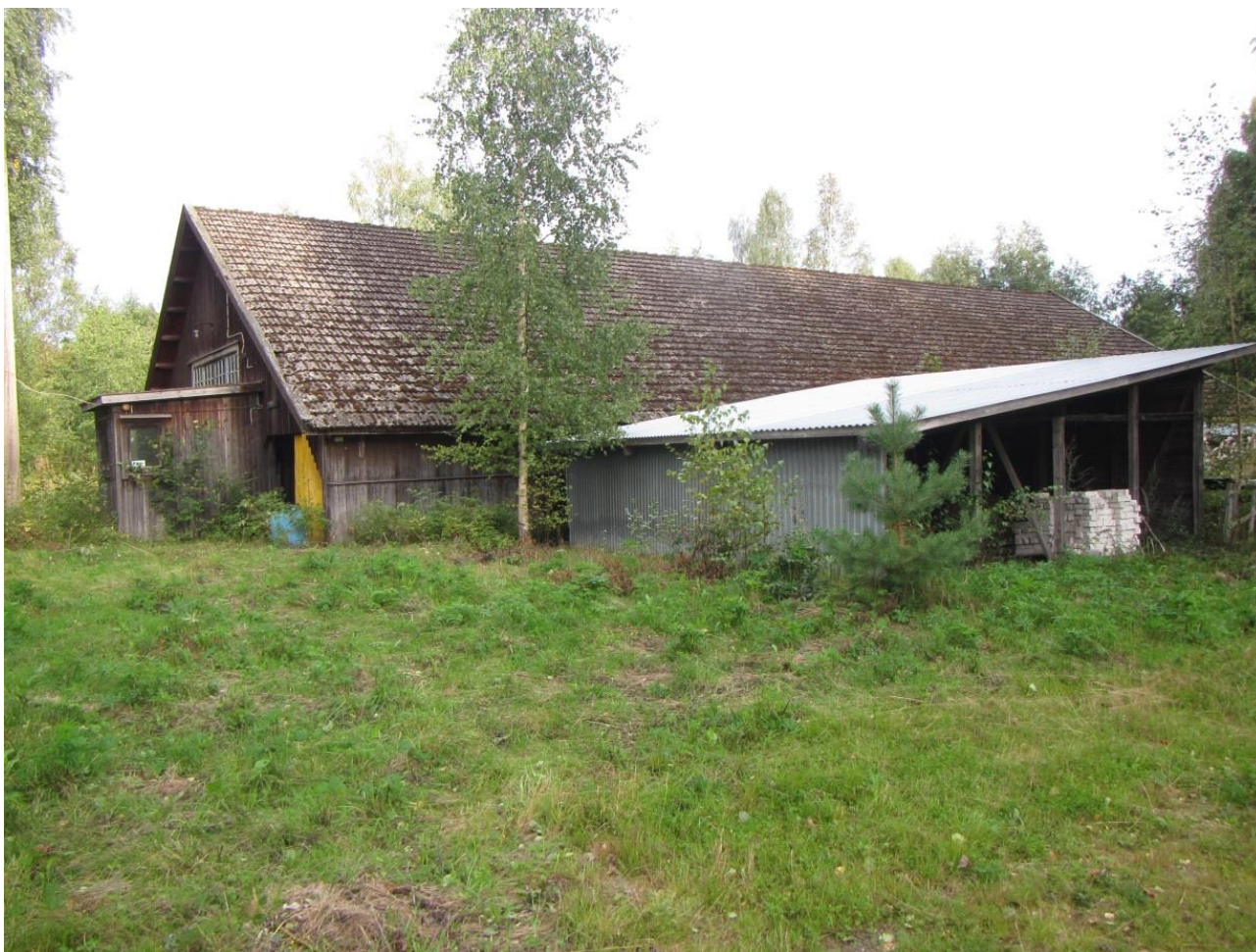
Kuva 6. Hylätty rakennus Kostianvirran rannan selvitysalueella.
